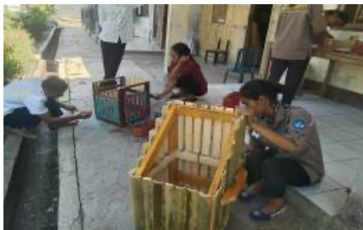
Gambar 4. Pengecatan tempat sampah
