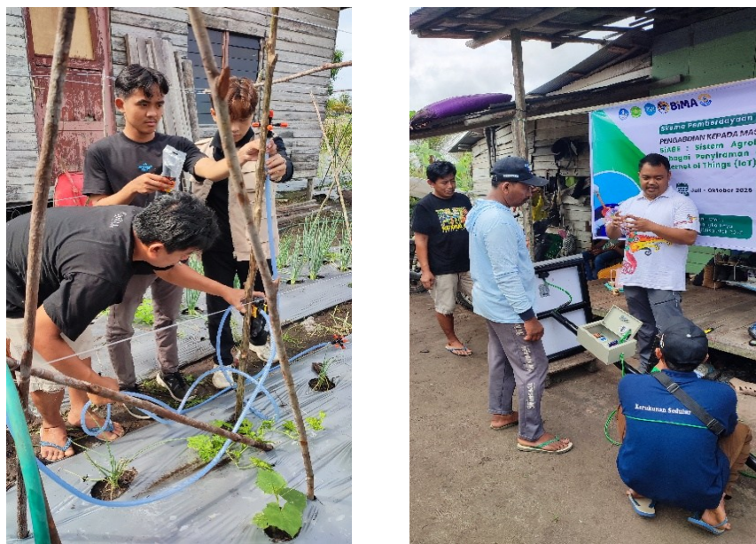
Gambar 8. (a) Pemasangan Selang dan Nozzle pada Beberapa Titik; (b) Pemasangan Kabel pada Komponen PLTS;
