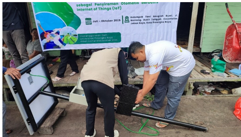
Gambar 7. Pemasangan Komponen PLTS pada Sistem SiABE
