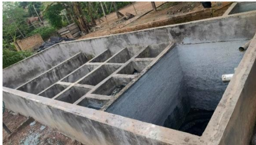
Gambar 1. Bak penampungan limbah sebelum dibuang ke penampungan limbah besar
