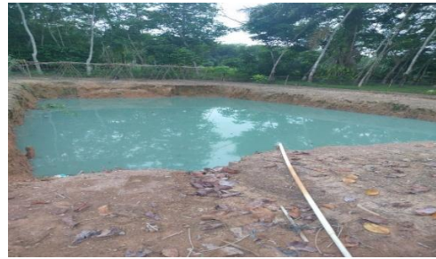
Gambar 1. Bak penampungan limbah sebelum dibuang ke penampungan limbah besar
