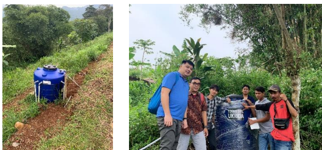
Gambar 8. Hasil Pemasangan Toren Filter (kiri) dan Toren Penampung (kanan)
