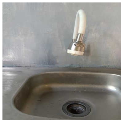
Gambar 4. Foto dinding area cuci tangan setelah perbaikan
